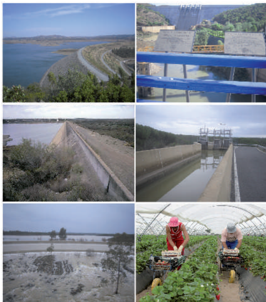
Figura 53. Infraestructuras hidráulicas del Sistema Andévalo-Chanza-Piedras-Machos y campos de fresas en Huelva
