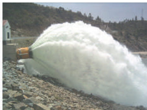
Figura 39. Desembalse de agua y obtención de energía hidroeléctrica. Embalse del Andévalo Fuente: Foto cedida por la C.R. del Surandévalo
