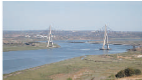
Figura 19. Puente Internacional sobre el Guadiana
