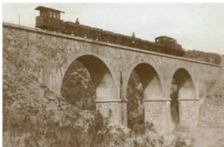
Figura 1.11. Ferrocarril en el puente sobre el barranco del Lobo en el año 1934. Archivo del Ayuntamiento de La Puebla de Guzmán
