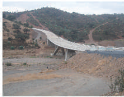
Figura 13. Nuevo puente sobre el Chanza entre Paymogo y Serpa (Portugal) Fuente: J.M. Jurado (Agosto, 2010)
