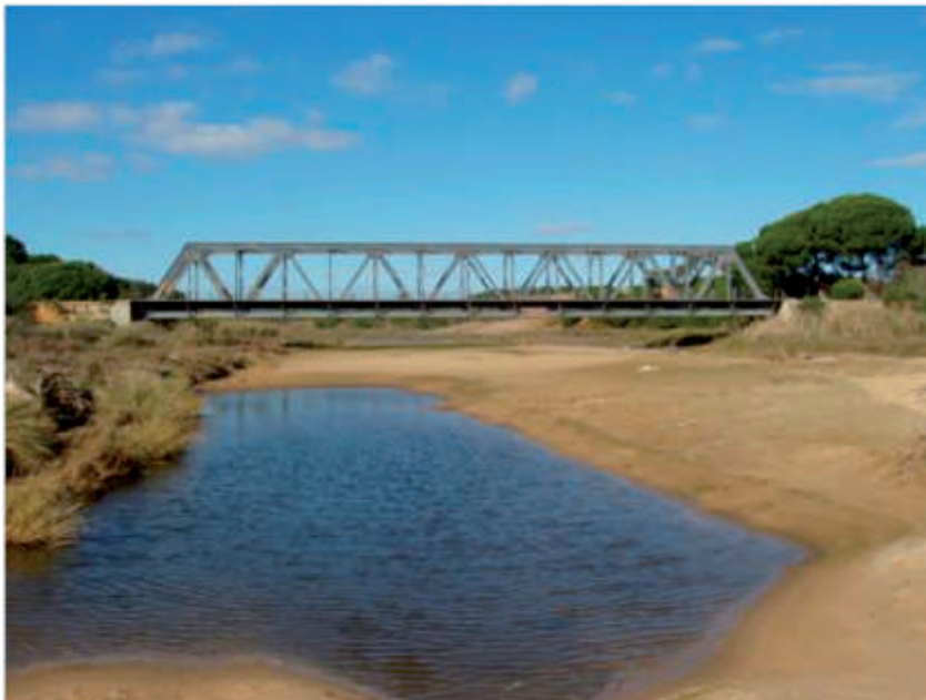
Figura 1.17. Puente Taviróna sobre el río Piedras, construido por Felguera en 1931. Autor J.R. Manzano. Fuente: Spanish Railway.
