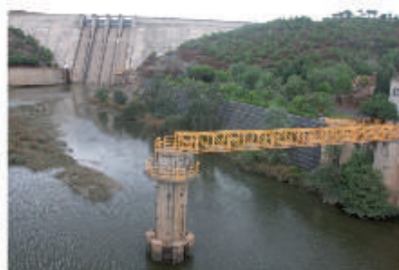
Figura 42. Embalse del Chanza y estructura de captación de aguas de Bocachanza Fuente: J.M. Jurado (Septiembre, 2010)
